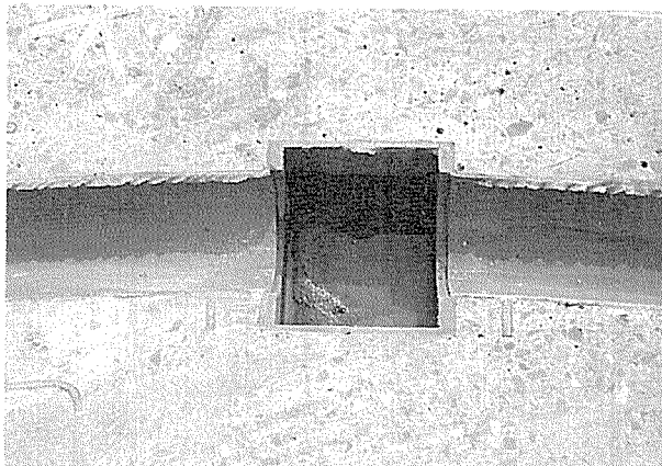
写真-5 貫通固定部切断状況
