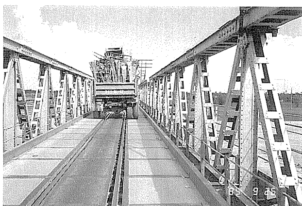
写真-8 ハノイ～ハイフォン間国道5号線(新アジア・ハイウェイ・ルートA-1)の鋼鉄道橋(道路橋としても使われている)
