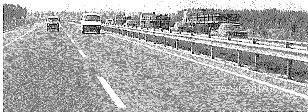
写真-4 天津～北京間的高速道路
