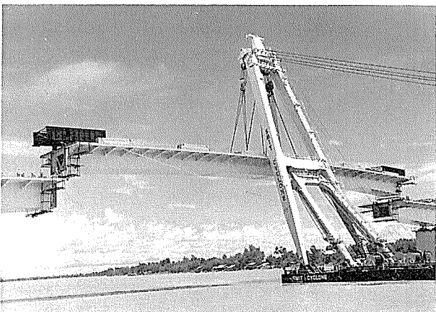
写真-11 国道 6 号線（新アジア・ハイウェイ・ルート A-11）チョルイ・チョンバ（日本）橋の鋼床版桁の架設状況〔提供：大林組〕
