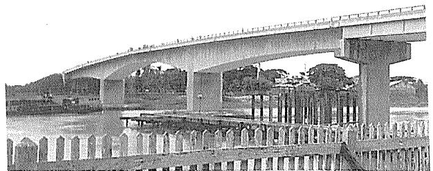
写真-15 1992 年度土木学会田中賞が与えられたナウワン橋（中央径間 110 m のディビダーク橋、橋長 350 m）
