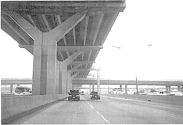
写真-13 タイ、バンコックの空港と市内を結ぶハイウェイ（新アジア・ハイウェイ・ルート A-1）上に建設中のドムアン有料道路
