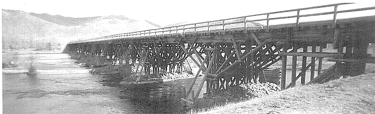
写真-3 ウランバートル～テレルシ（観光地）の道路に架かる350m幅員7mの木橋（モンゴルの幹線道路には今も多くの木橋が存在する）
