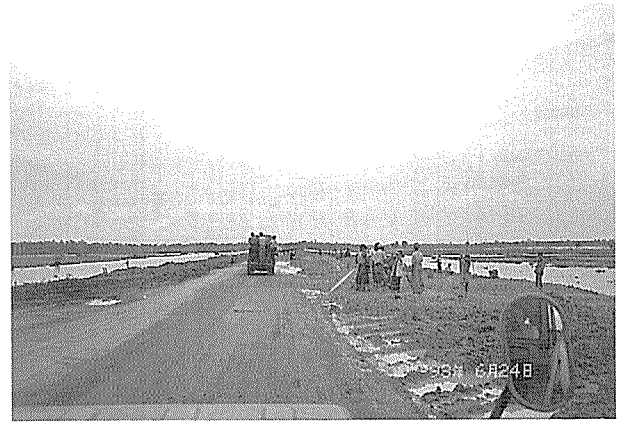
写真-14 ヤンゴン～パゴア間新アジア・ハイウェイ・ルート A-1 の 6 車線化工事
