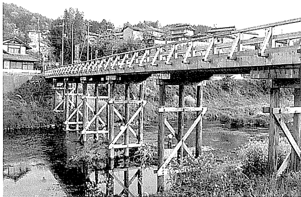
写真-3 古城橋（津山市）
