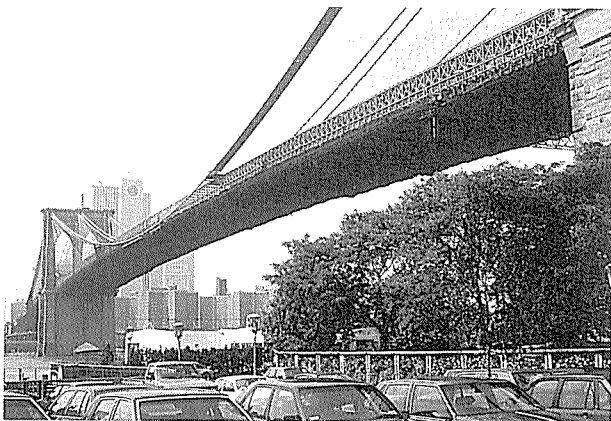
写真-4 ローブリング設計のブルックリン橋
