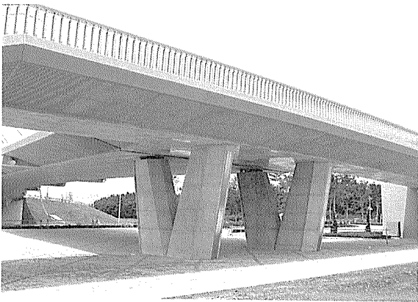
写真-11 V形橋脚／ふれあい橋
