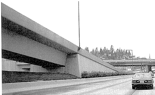
写真-6 橋台部の納め方 (アメリカ/シアトル)
