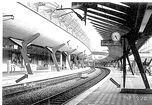
写真-9 橋脚下端部の納め方/カラトラバ設計の駅舎 (スイス/チューリッヒ)
