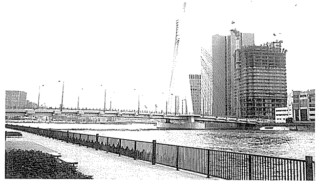
写真-14 隅田中央大橋・東京隅田川 周辺の状況を考えて、橋本体のシルエットが映えるような構図は望みがたい。その場合はこのような恣意的な形の橋にするよりも、もっと中立的で自己完結性の強いものとしたほうがよかったのではないだろうか。
