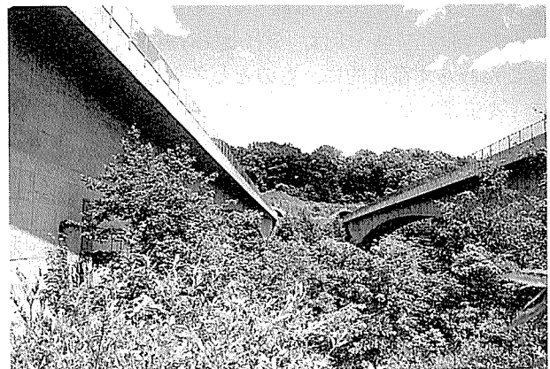
写真-12 ポロト橋・北海道
