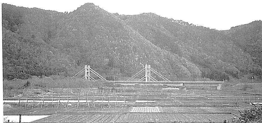
写真-5 小本川橋梁・岩手県 それ自体は骨ばった個性的な形態をしている PC 斜張橋であるが、山のふもとの田畑のなかでは、木立のように妙におさまって見える。橋のスケールと形、質感のためであろう。
