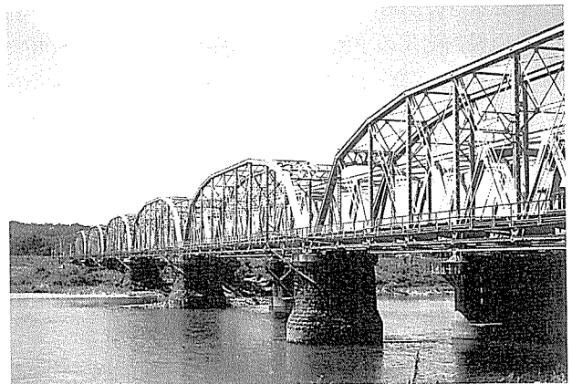
写真-13 神通川橋梁
