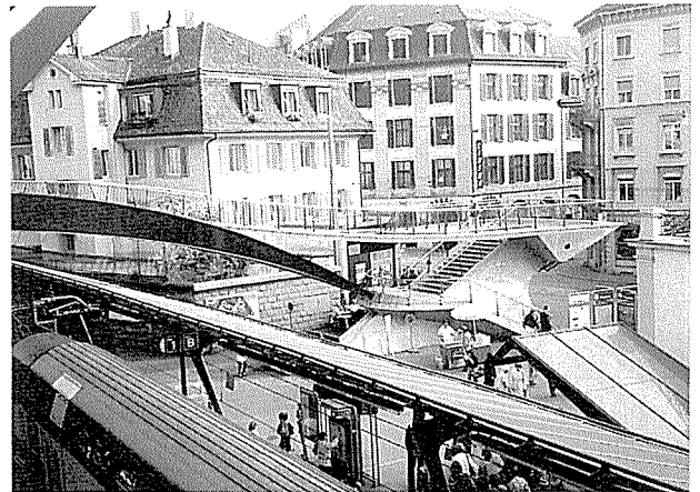
カラトラバの設計によるアーチと吊床版を組み合わせた橋 <シュターデルホーヘン駅の橋, スイス> (写真提供: 川上佳史氏)
