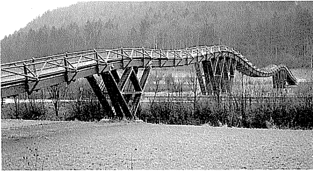
エッシングの木製吊床版橋<ドイツ> (写真提供:菊地 弘氏)
