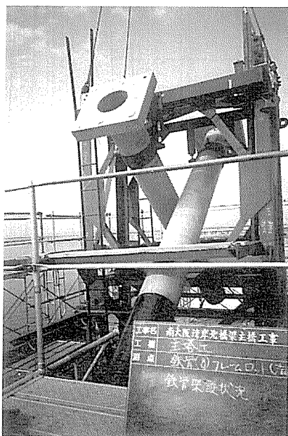
写真-2 鉄骨据付け状況
