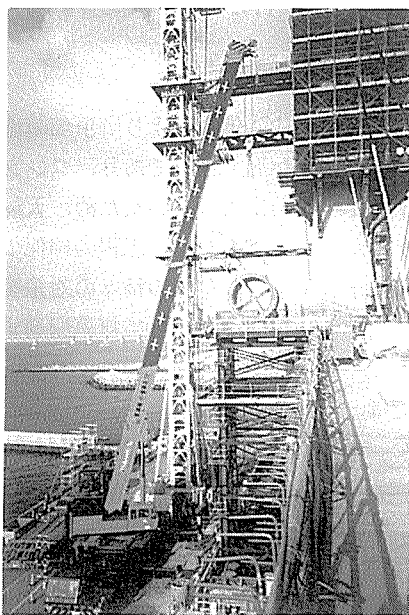
写真-7 荷揚げ構台
