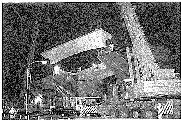
写真-6 U形桁の架設状況
