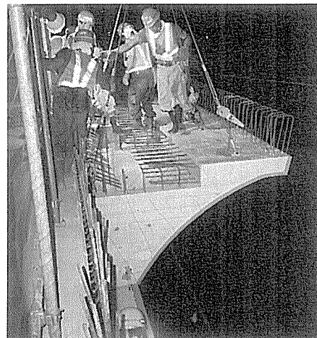
写真-3 プレキャスト部材架設状況
