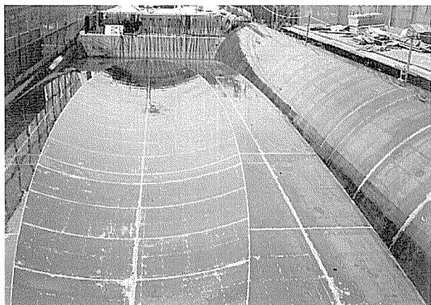
写真-1 型枠の設置状況
