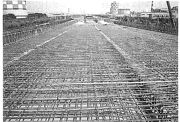
写真-6 上床版配筋配管
