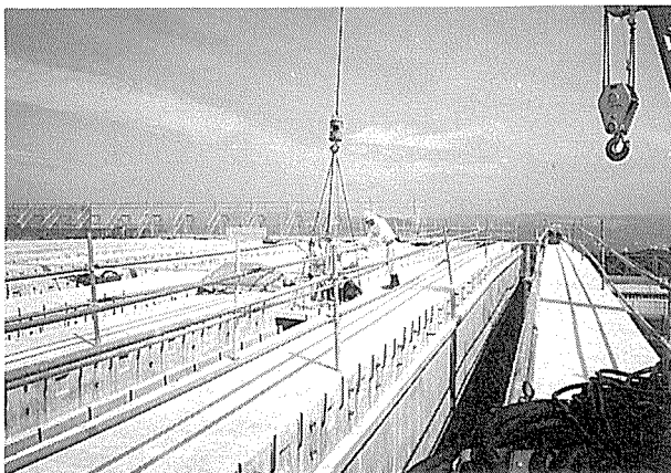
写真-11 Pca 床版の敷並べ
