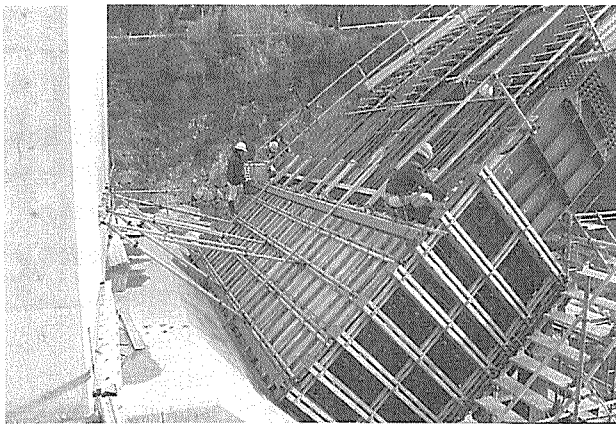
写真-6 スプリング部の支保工施工
