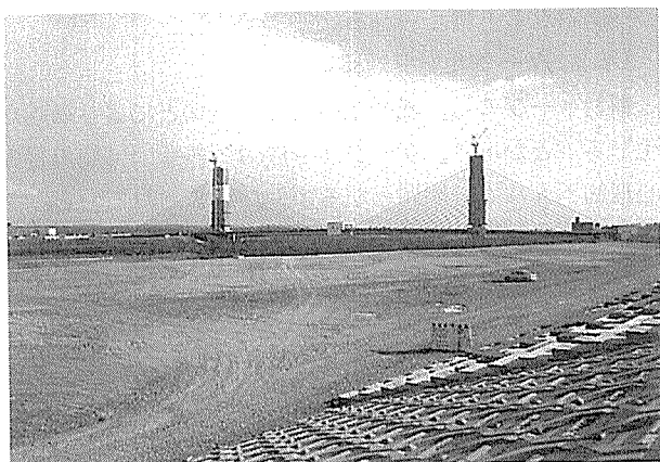
写真-10 工事全景(1994年12月)
