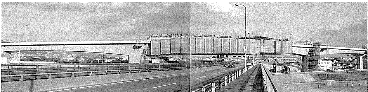
写真-1 大型移動防護構
