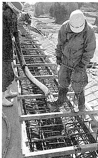
図-5 型枠に接したコンクリート表面の気泡跡のでき方
