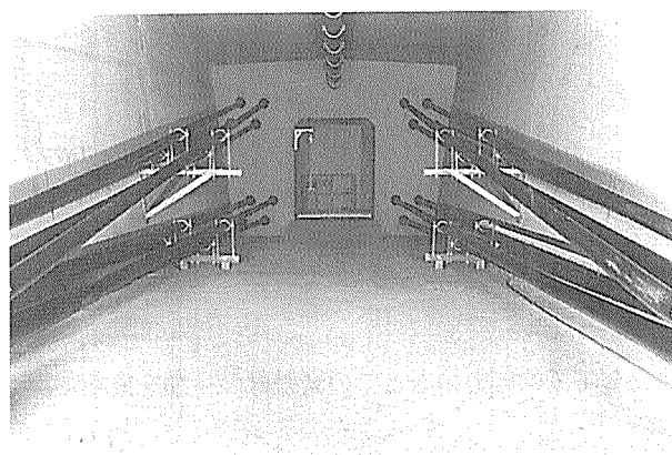
写真-3 外ケーブルの配置状況
