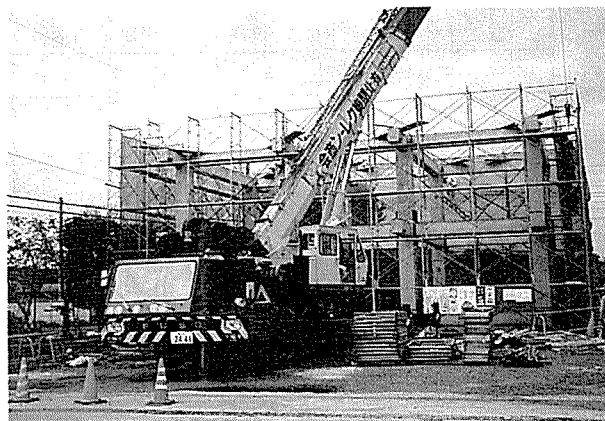
写真-6 骨組み完了時
