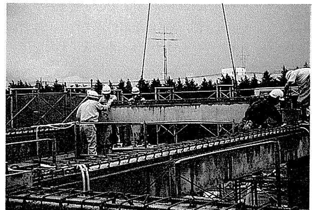
写真-4 梁部材の架設
