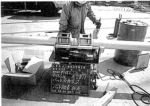
写真-6 PE管溶着接合状況
