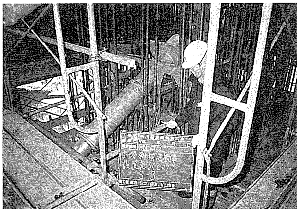
写真-2 主塔斜材定着体据付け状況
