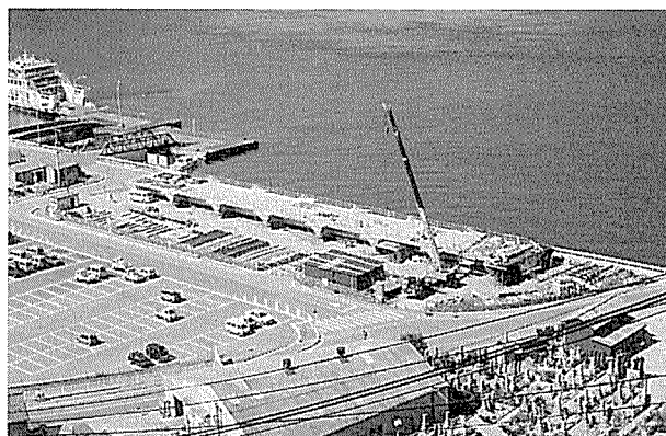
写真-3 主桁セグメントの製作状況
