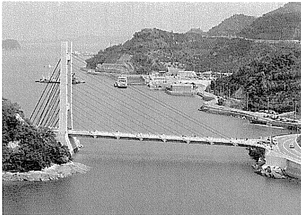
写真-10 平羅橋 (完成直前状況)
