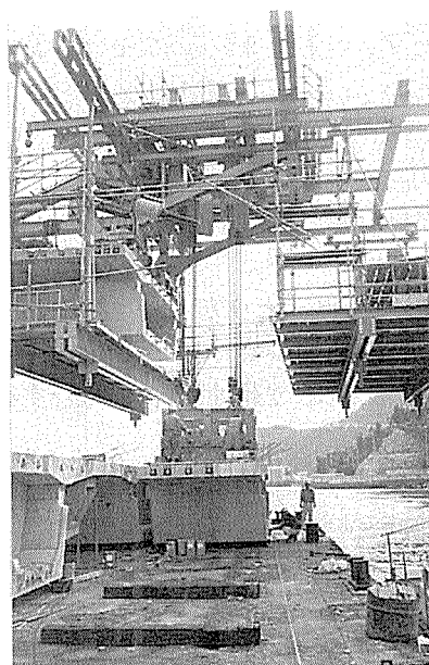
写真-6 エレクションノーズによる主桁セグメントの架設状況
