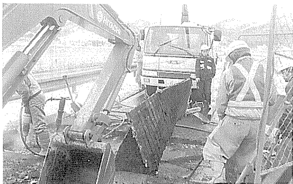
写真-5 宮の沢高架橋補修工事
