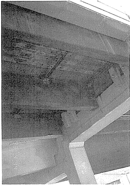
写真-1 施工前の状況
