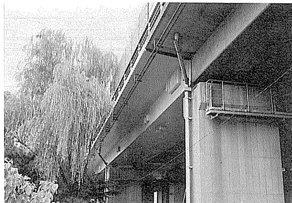
写真-2 完成写真
