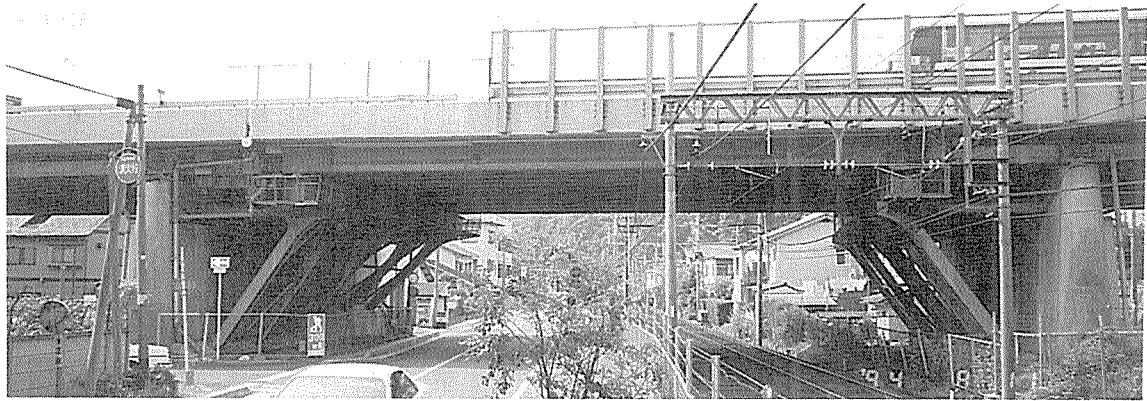
写真-1 吊桁部の現況
