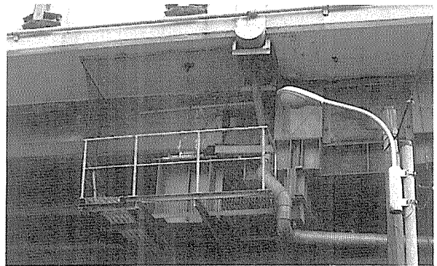
写真-2 ゲルバー部
