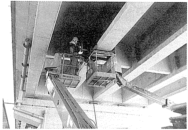
写真-4 X線透過法による主桁の調査
