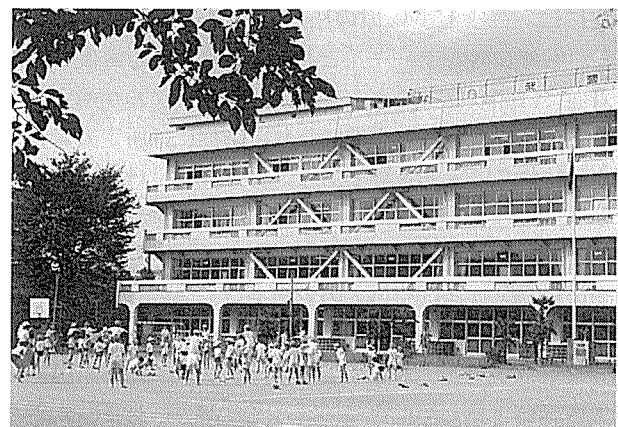
写真-1 武蔵野市立第三小学校
