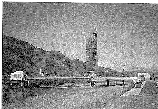
写真-4 斜材の架設
