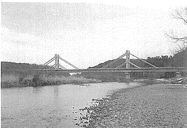
写真-1 小本川橋梁
