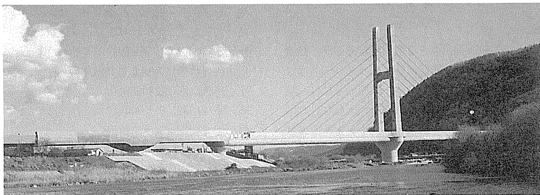
写真-2 第2千曲川橋梁
