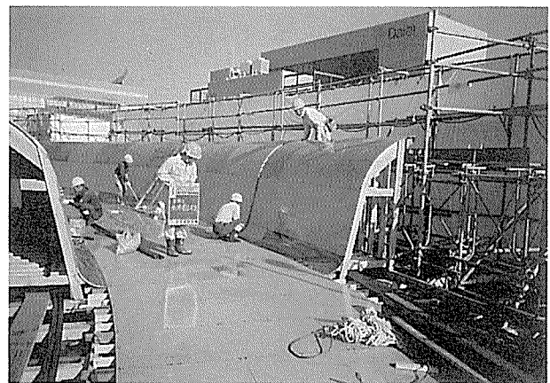
写真-4 側枠の設置
