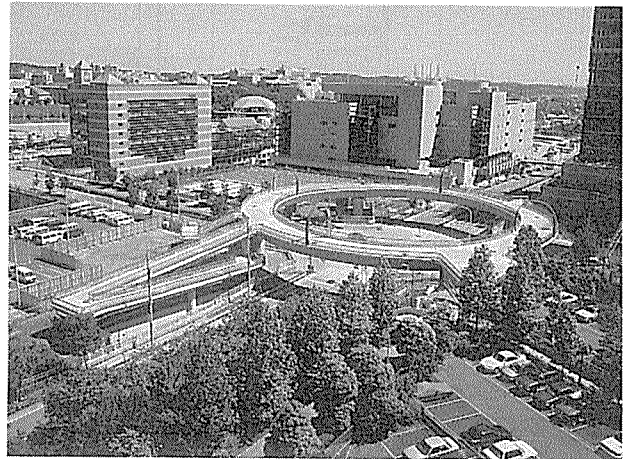
写真-1 橋梁全景
