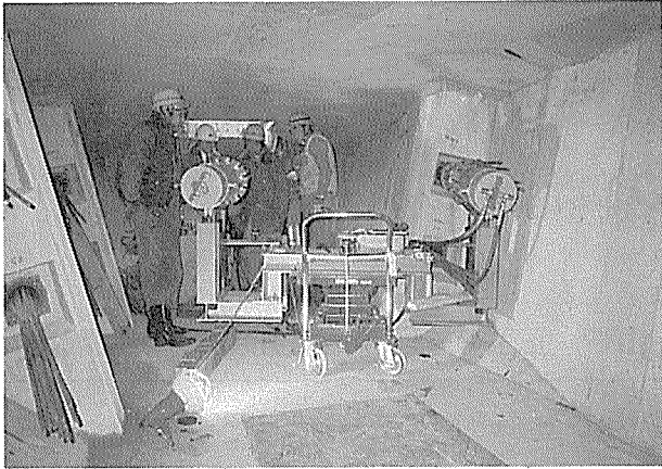
写真-6 主ケーブル緊張状況
