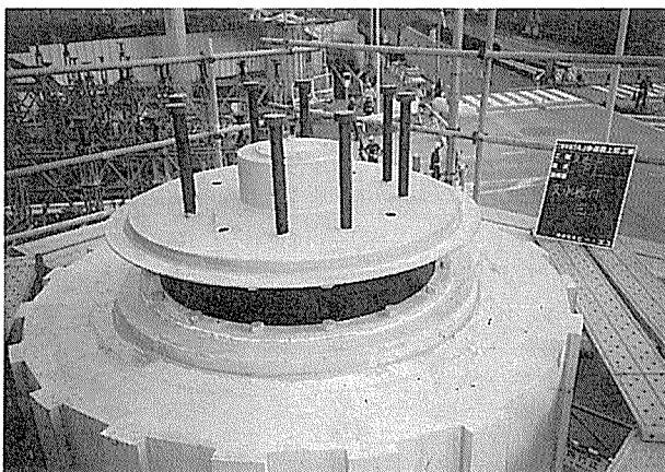
写真-3 支承の配置
