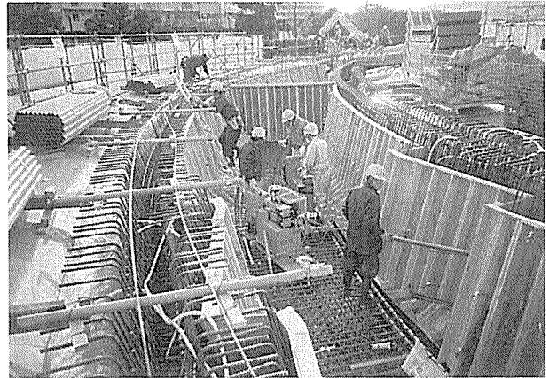
写真-5 内枠の設置
