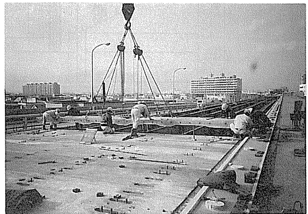
写真-1 新琴似高架橋におけるプレキャスト床版の施工
