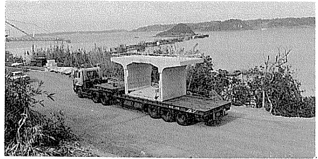
写真-5 トレーラによる運搬
