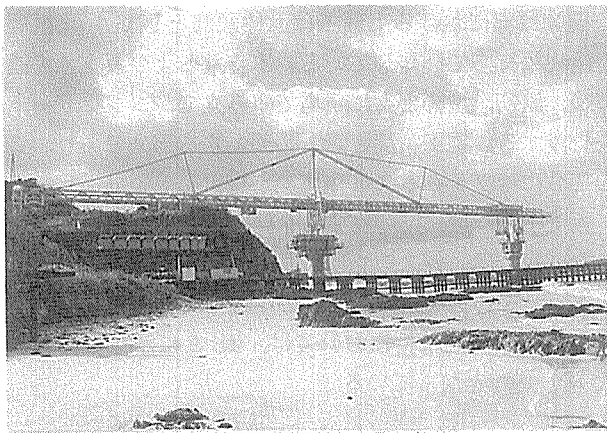
写真-7 架設桁全景
