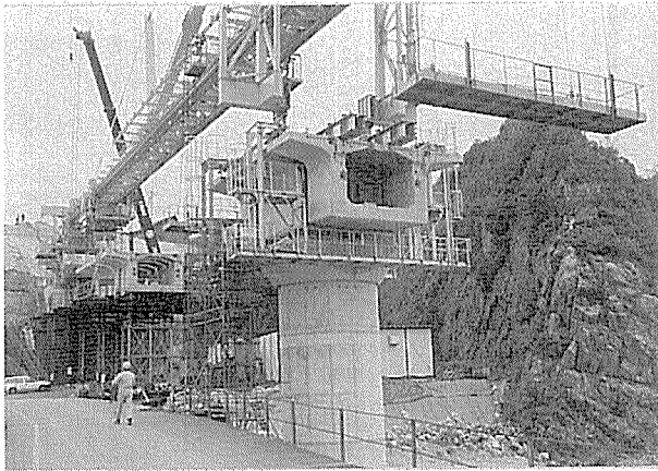
写真-6 架設桁による架設
