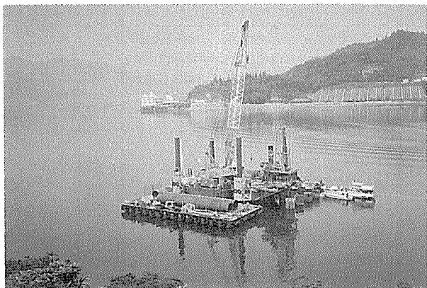
写真-2 基礎杭施工状況
