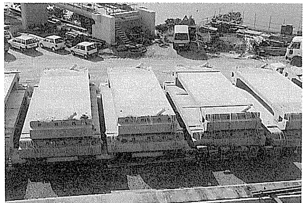
写真-8 主桁ブロック仮置き
