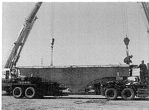
写真-6 部材の積み込み
