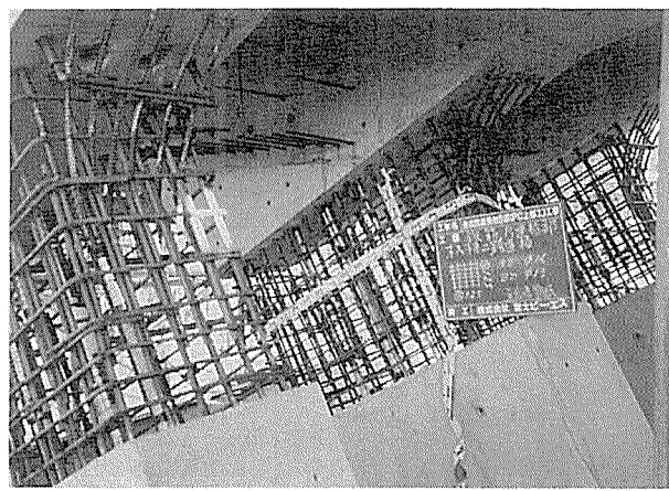
写真-9 脚部の接合
