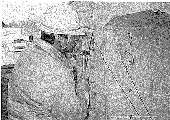
打音法によるグラウト充填状況の測定
