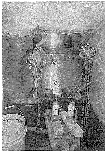
写真-7 マルチストランドジャッキ
