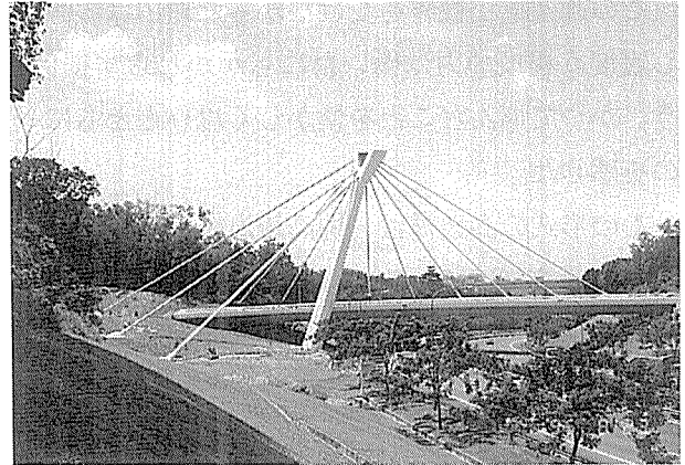
写真-1 サフティリンク橋全景 (その1)
