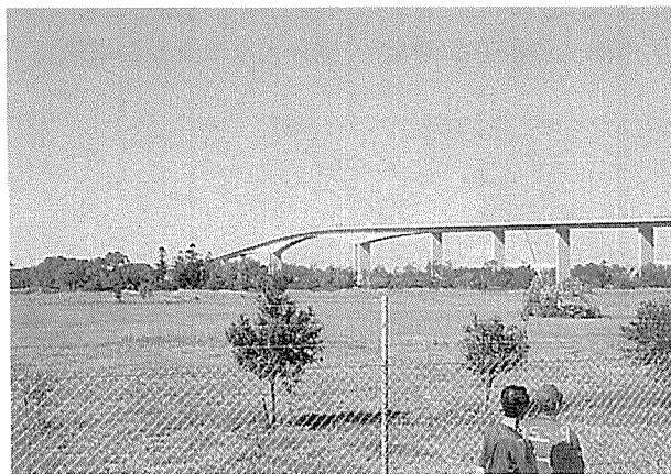
写真-9 Gate Way 橋
