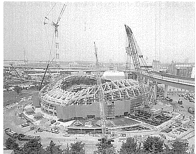
写真-1 PCフレーム完成状況
