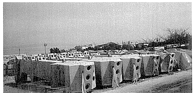
写真-3 PC 大梁ストック状況
