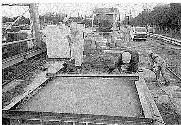
写真-5 コンクリート打設状況
