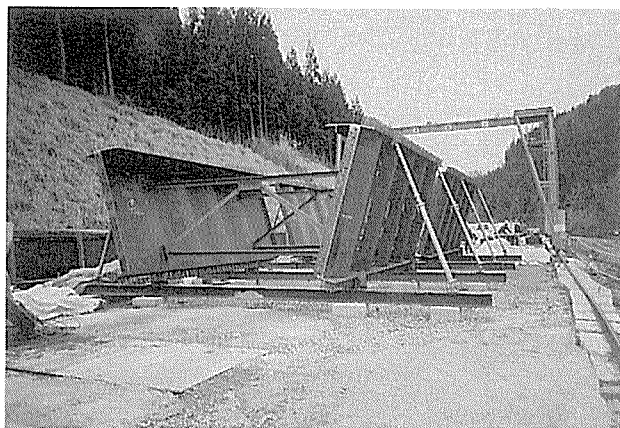
写真-2 波形鋼板ウェブ
