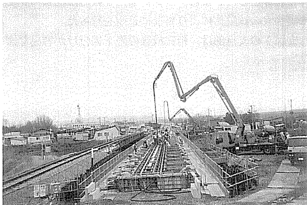
写真-2 レール受桁打込み状況
