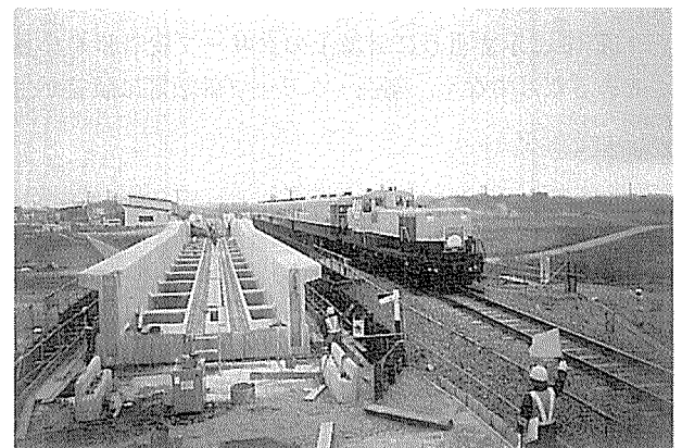
写真-4 主桁完成時
