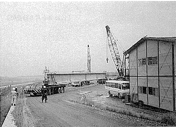
写真-3 製作ヤードから搬出
