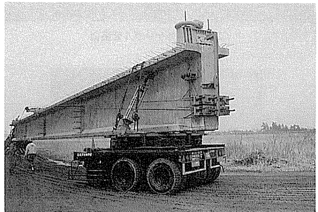
写真-5 架設地へ
