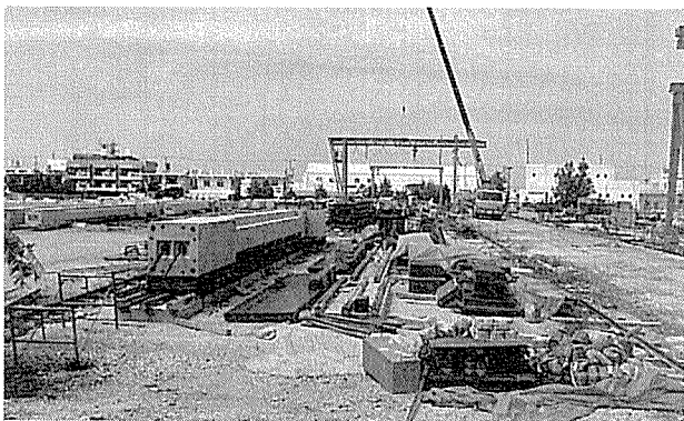
写真-4 柱 PC 鋼材挿入完了
