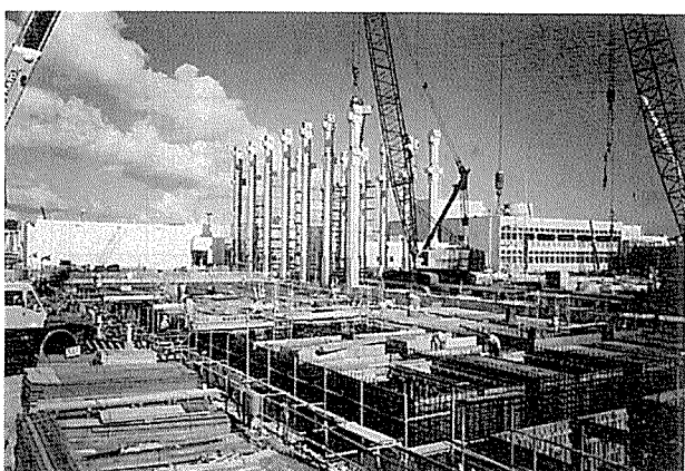
写真-5 柱の架設
