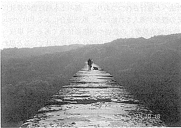
写真-2 水道橋の天端
