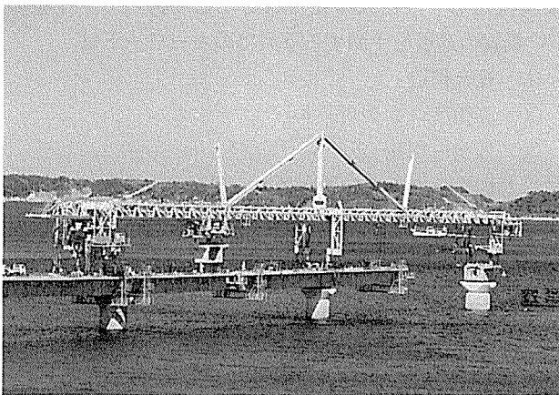
写真-5 角島大橋
