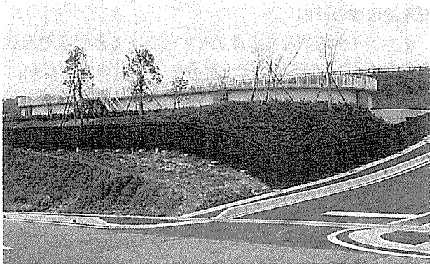
写真-5 小判型の吐水槽。斜面の中腹に半地下構造で納められ、地形、緑環境と見事に調和している。仮にあと3m 地上に現れたとしたら、その存在感は圧倒的なものになっていただろう。
