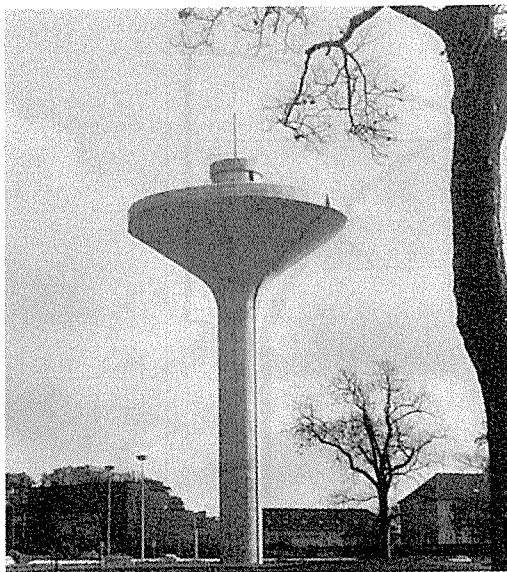
写真-13 このフォルムはリフトアップ機構とセットで計画された。構造デザインは正にエンジニアの仕事である。
