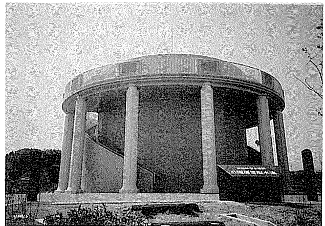
写真-8 公園内にある展望施設を有する配水池。
