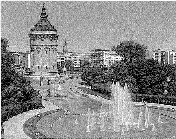
写真-3 1889年(明治24年)に建設されたマンハイムの配水塔。石造りの外殻の中には容量2000 m 3 の円筒形鋼製タンクが納められている。
