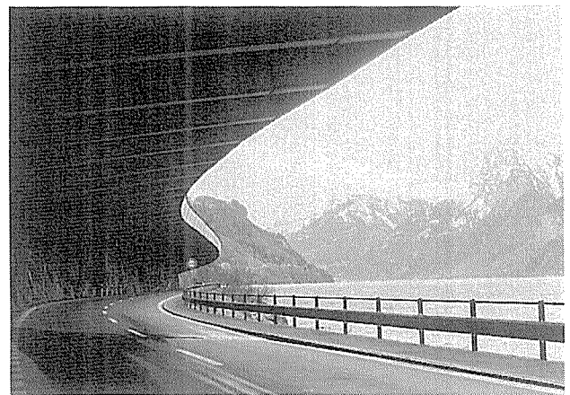
写真-11 プレキャスト製片持ち梁式シェッド (スイス)
