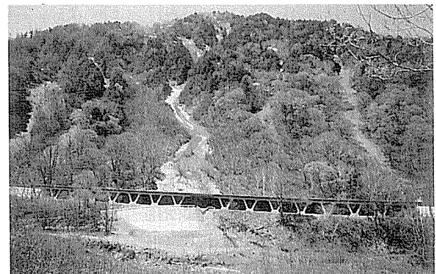
写真-3 谷側柱をプレキャストPC製V字斜材形式としたシェッド
