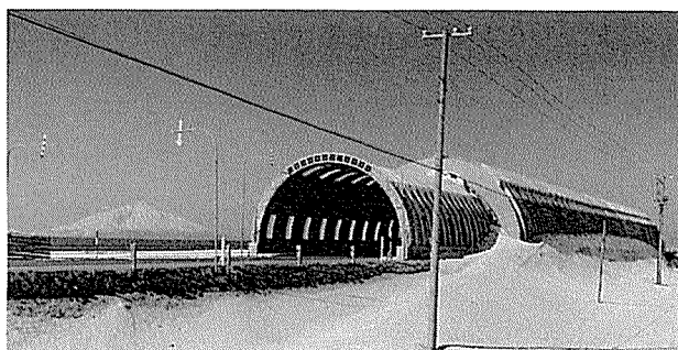
写真-8 パーキングシェルター
