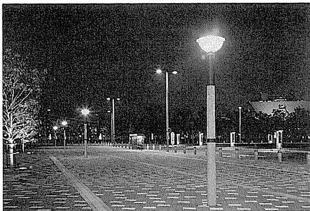
写真-5 PCのシステムポールが配置された臨海副都心の道路（2）
