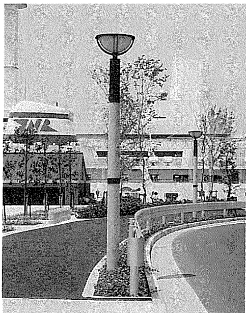
写真-10 東京都臨海副都心道路 3.5 m 歩道用照明
