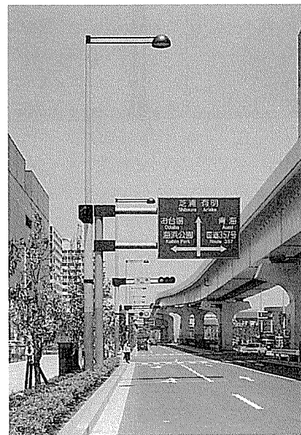
写真-6 東京都臨海副都心道路 12 m 幹線道路用照明（親交通ライトアップ照明付きタイプ）
