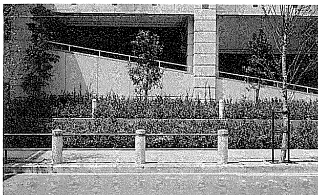
写真-12 東京都臨海副都心道路 車道境界防護柵
