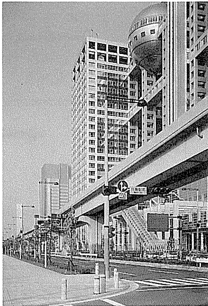
写真-4 PCのシステムポールが配置された臨海副都心の道路（1）
