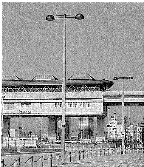
写真-9 東京都臨海副都心道路 10 m 駅前広場照明
