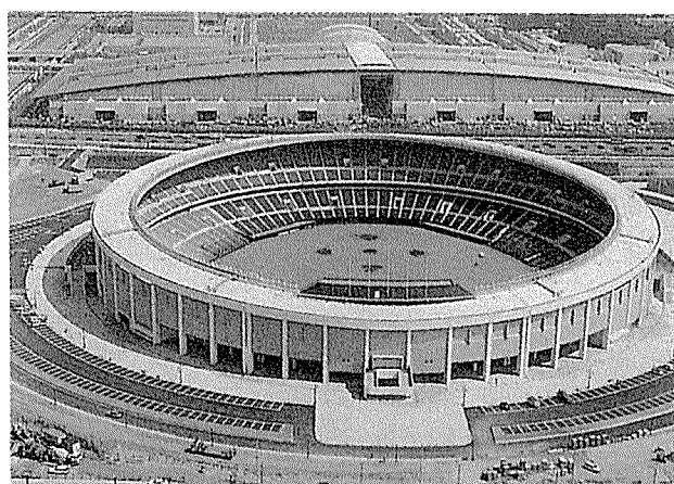
写真-3 PC段床(千葉マリンスターム) 17)
