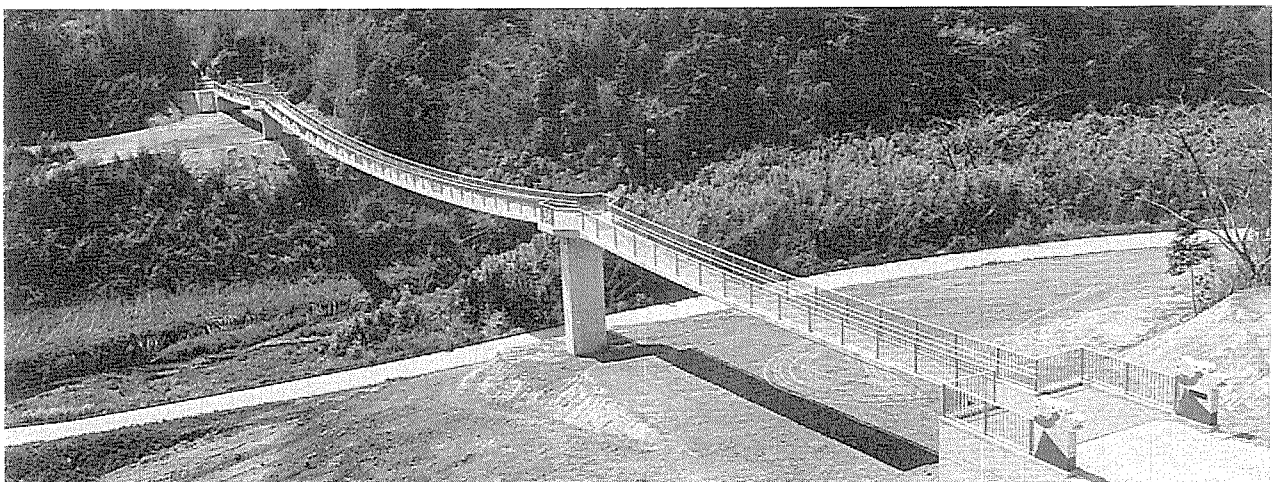
写真-1 完成写真
