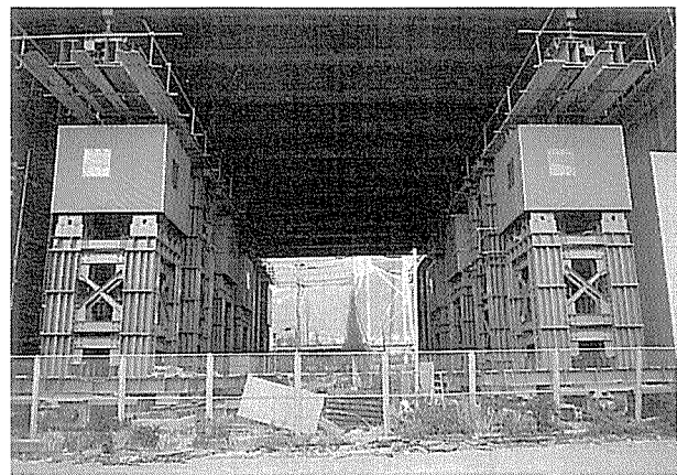
写真-5 リフターシステムの配置
