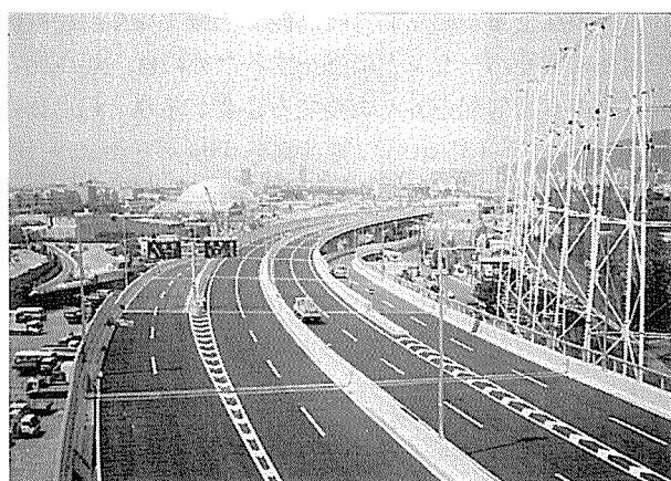
写真-9 摩耶工区全景
