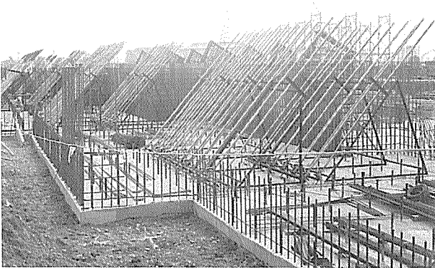
写真-4 PC 鋼棒の配置
