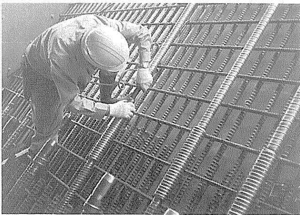
写真-5 PC 鋼棒, シース管の接合部
