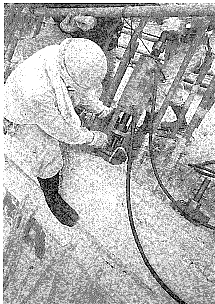
写真-8 センターホールジャッキによる張力導入
